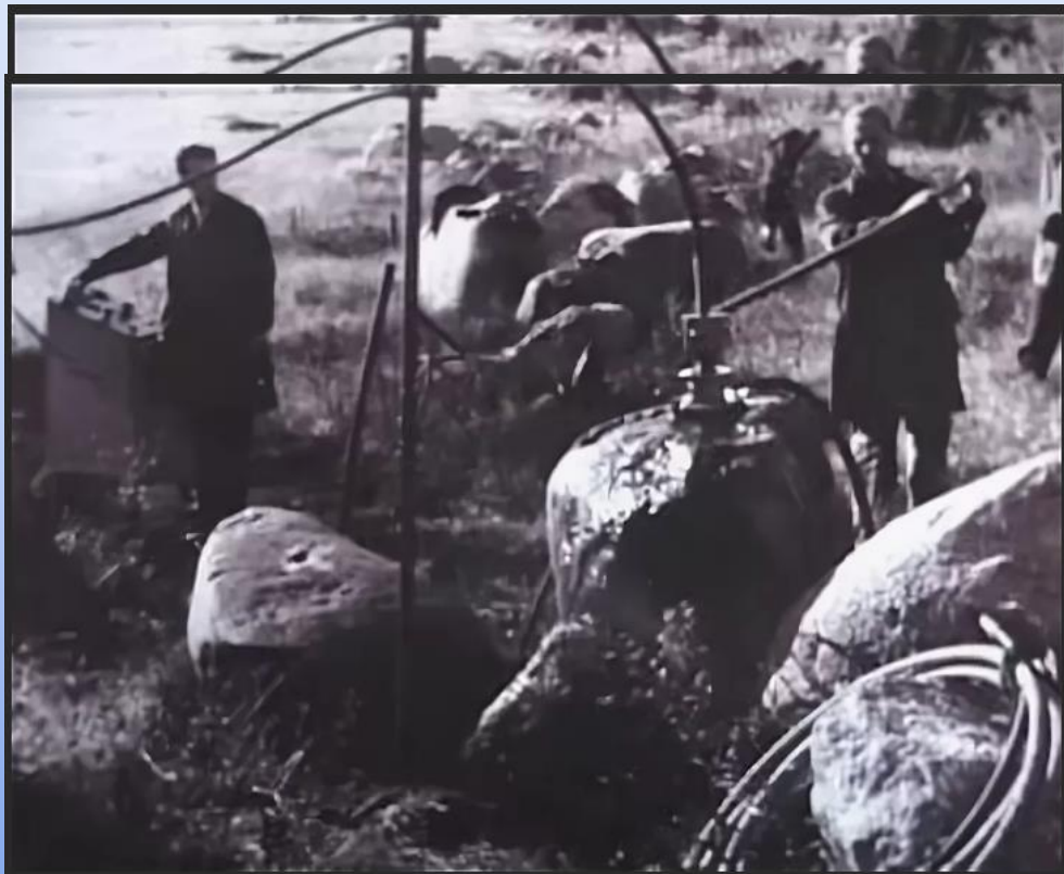
Фото разрушения гранитного валуна при помощи ЭГУ
